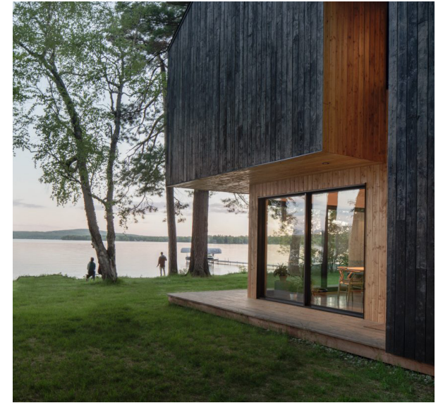
3 | Loggia die binnen zorgt voor meer schaduwwerking.
