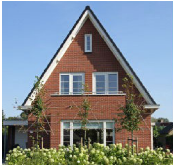
5 | Aanbouw is ondergeschikt aan het hoofdvolume.
